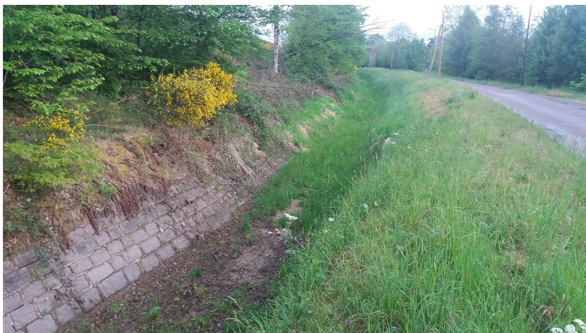
Rigole d'alimentation du Réservoir de Bouzey, avril 2020
