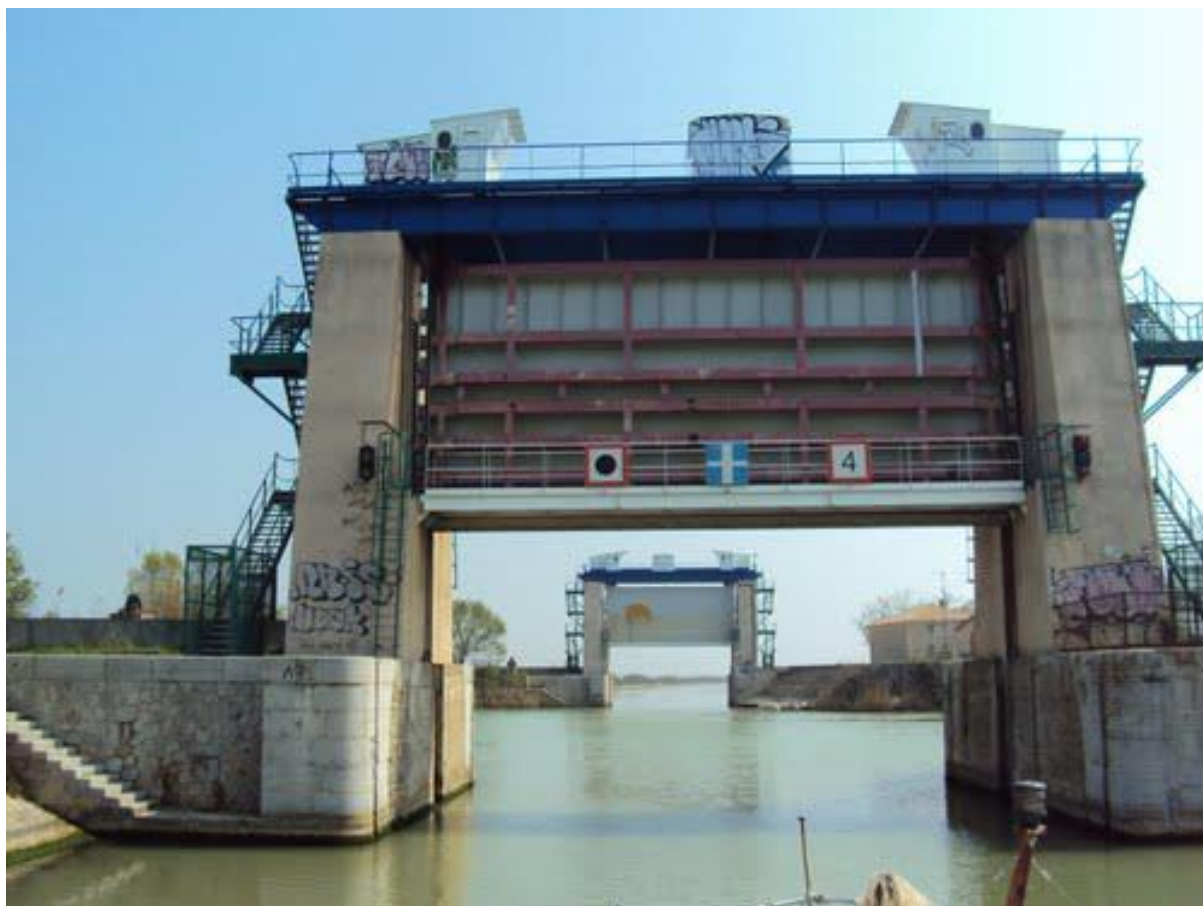
Portes de garde de la Vidourle
