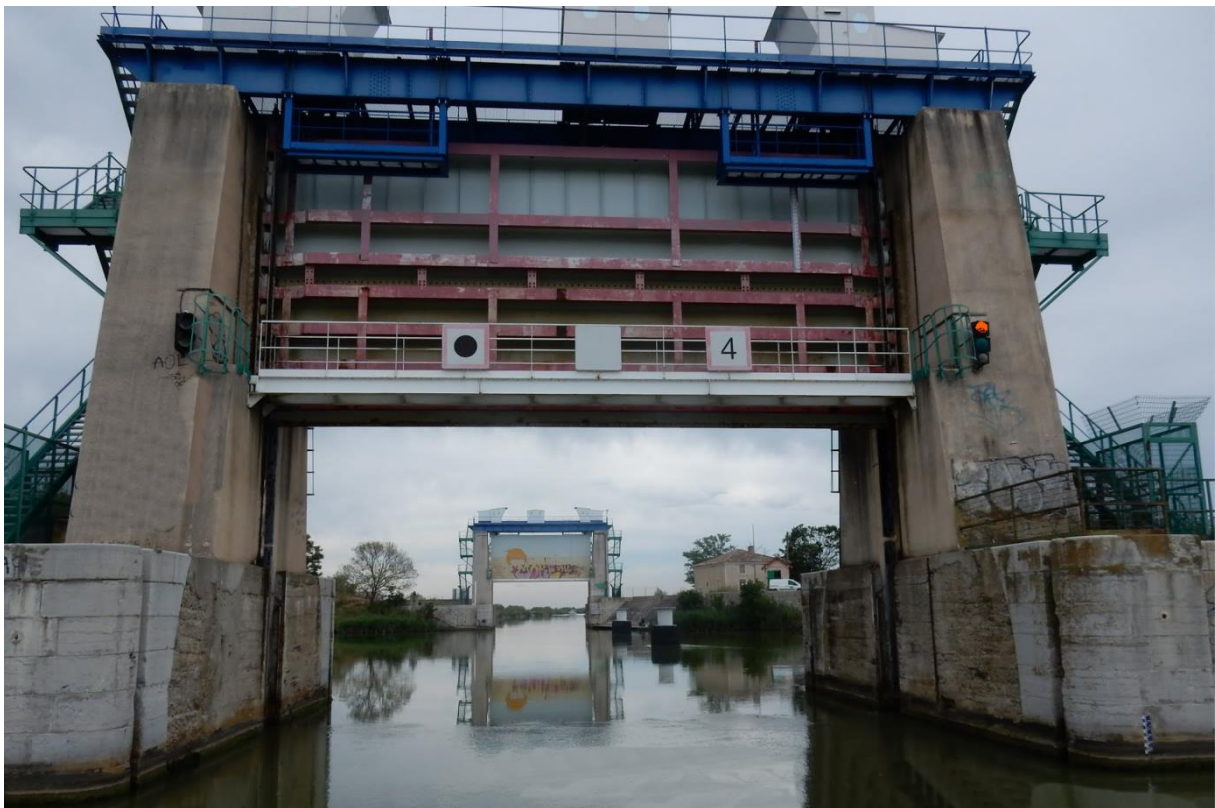
Image 59 - Vidourle, portes de garde
