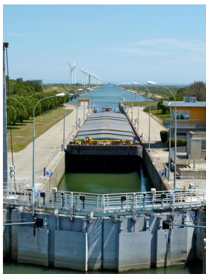
Image 45 - Canal Rhône-Fos-Port-de-Bouc écluse de Barcarin
