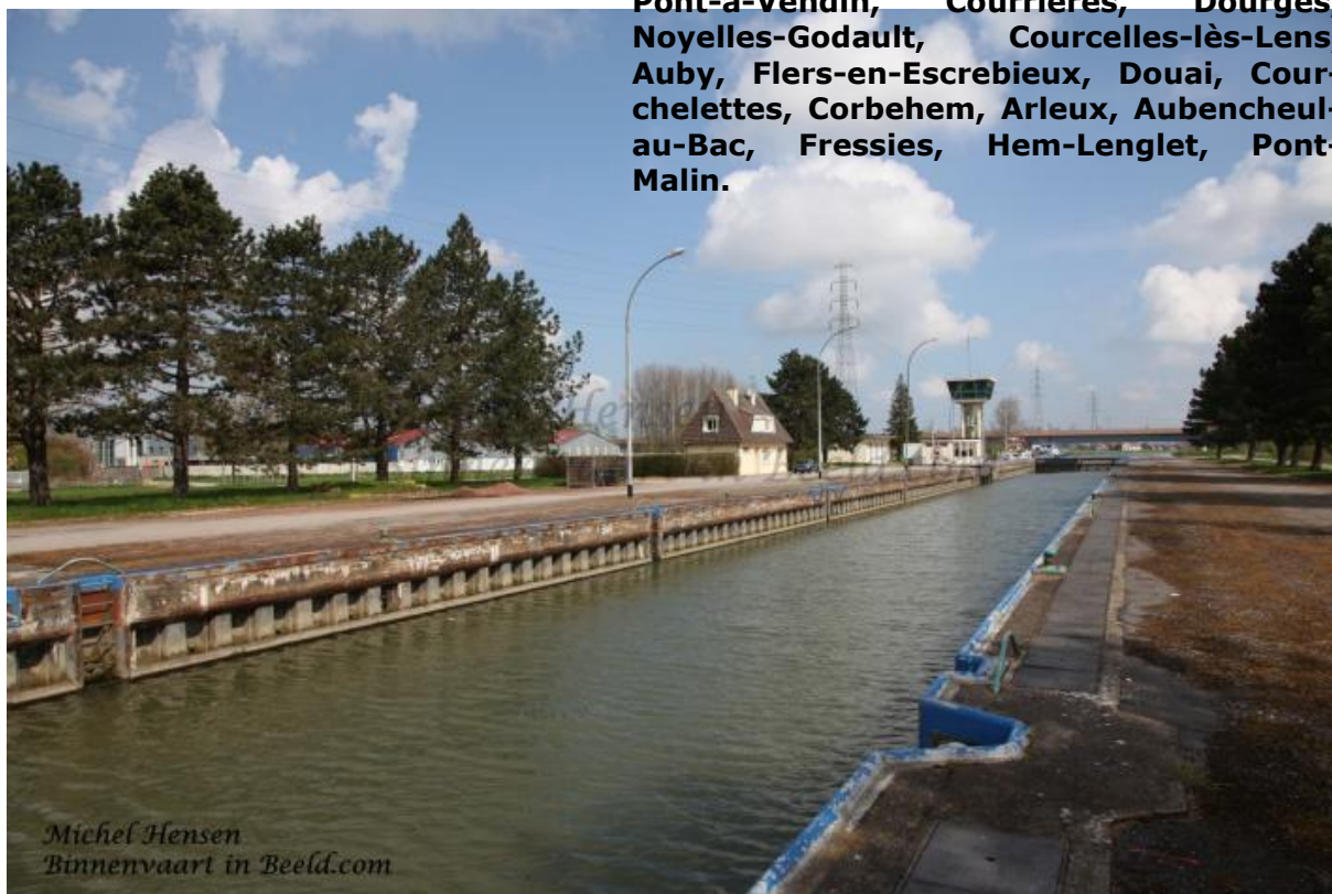
Image 20 - Dunkerque-Escaut, écluse de Watten
