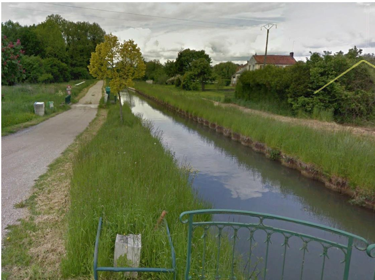
Image 15 - Canal du Clignon
