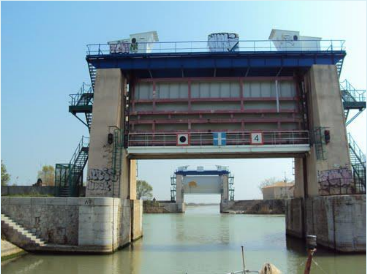
Portes de garde du Vidourle
