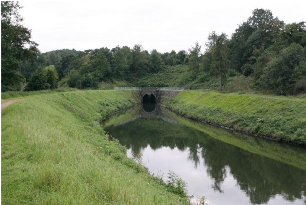
Le tunnel de Ham
