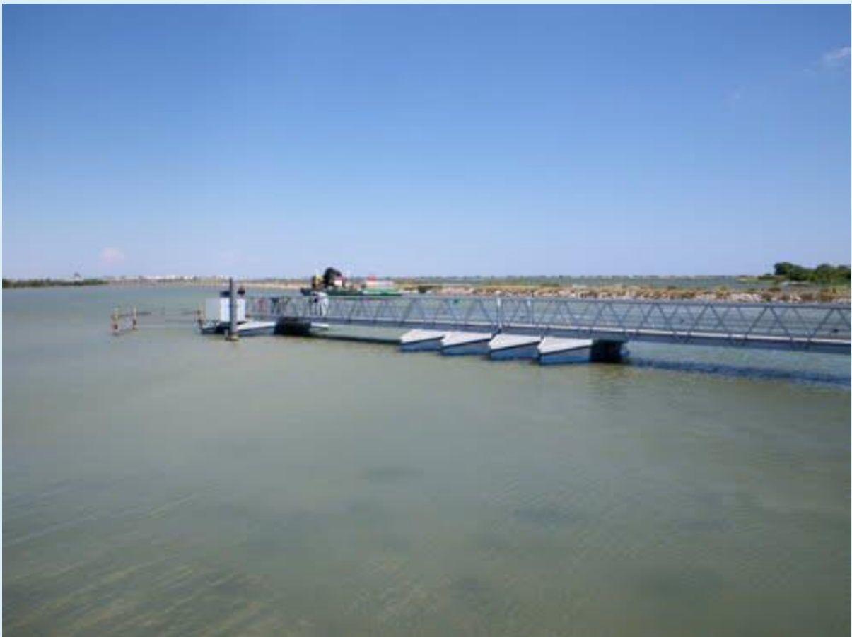
La passerelle flottante de Maguelone
