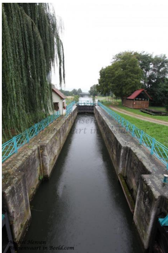
Figuur 16 - Canal de Colmar, sluis Foto: binnenvaartinbeeld.com
