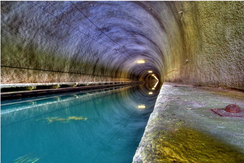
Figuur 50 - Canal Saint-Quentin, tunnel van Macquincourt
