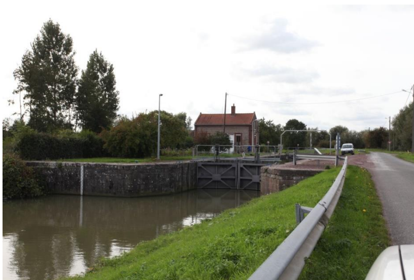
Figuur 32 - La Lys, sluis Fort Gassion
