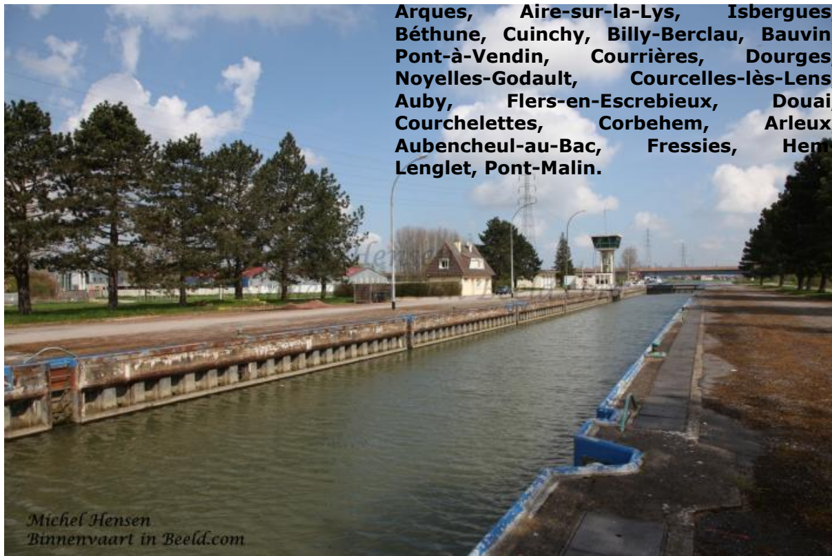
Figuur 20 - Dunkerque-Escaut, sluis Watten
