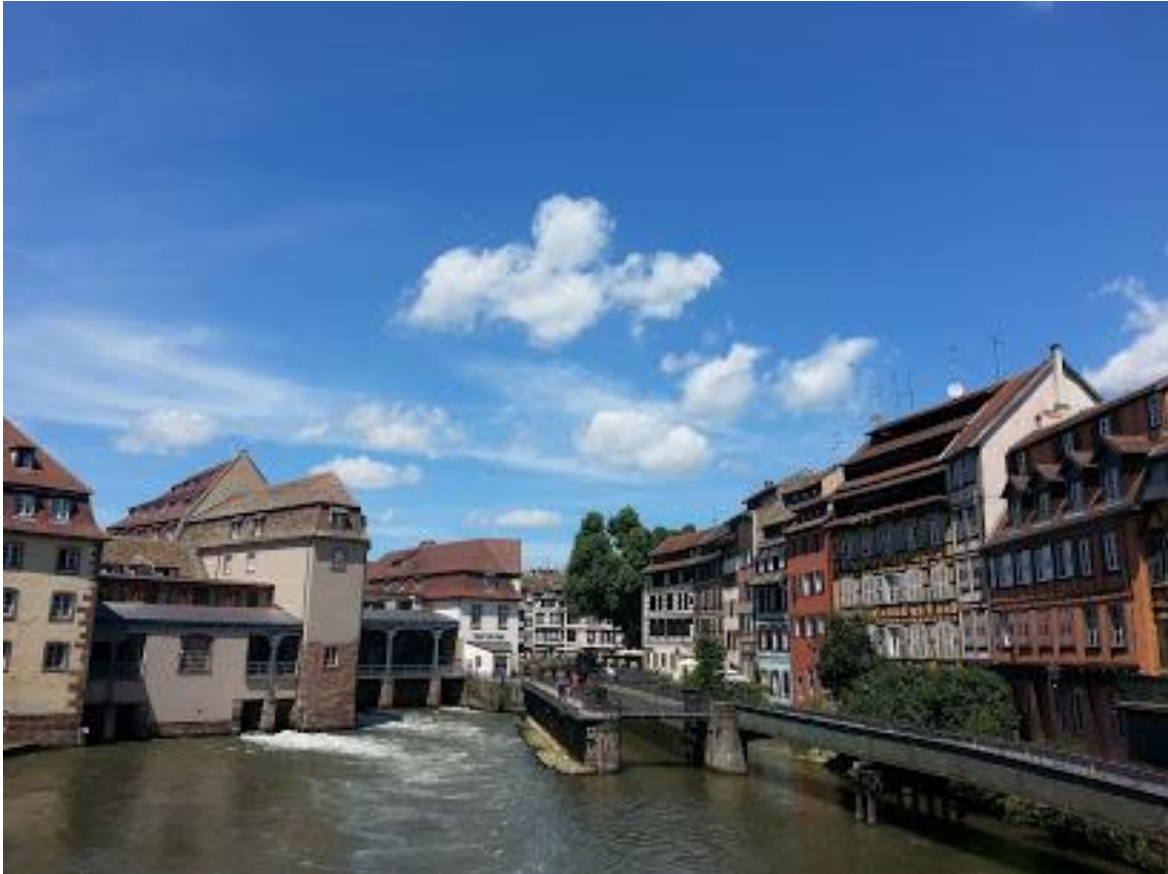
Figuur 26 - Straatsburg, sluis A La Petite France
