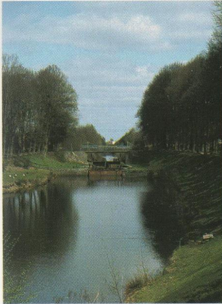
Net over de grens met Duitsland bevindt zich nog een volledig vervallen sluisje vlak voor Nordhorn. Kennelijk bevond het scheidingspand van het kanaaltje zich op de landsgrens, want achter de sluis is het kanaalpeil weer lager.
