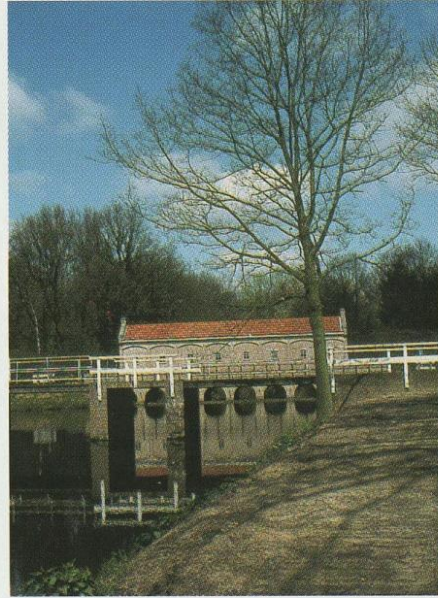
Waar de Dinkel het Kanaal Almelo–Nordhorn kruist, is een regelstuw gebouwd die doet denken aan de Ecluse-Barrage in het Zuidfranse Canal du Midi. De prachtige boogconstructie bevat de regelbare kleppen.
